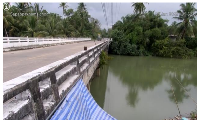
TC191705 : สะพานปากน้ำสิชล ต.สิชล อ.สิชล จ.นครศรีธรรมราช
